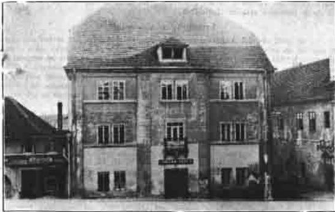
Školní budova, kde byl narozen August Geringer.
